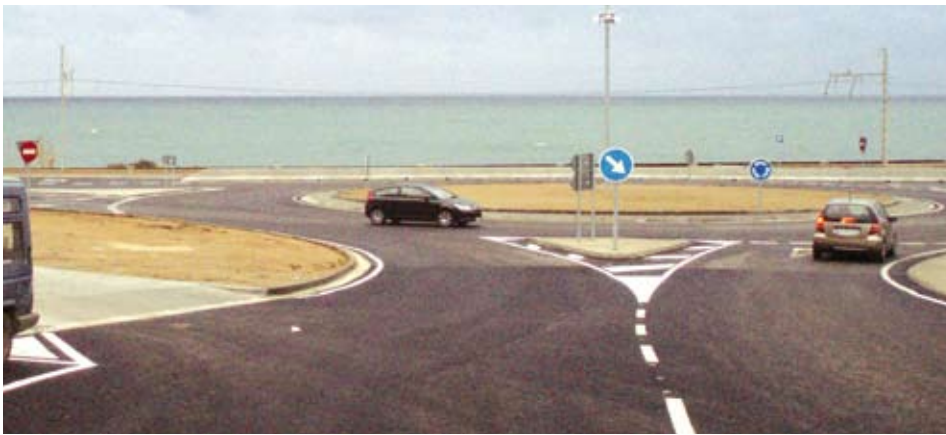
Aspecte de la nova rotonda de l'N-II a Llavaneres.
