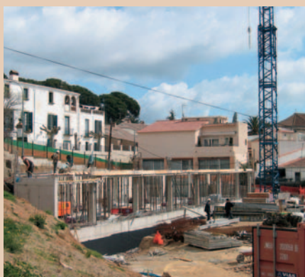
Les obres de la futura biblioteca
