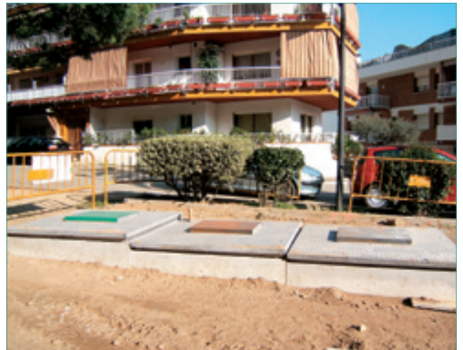
Vista de les obres de soterrament dels contenidors.
